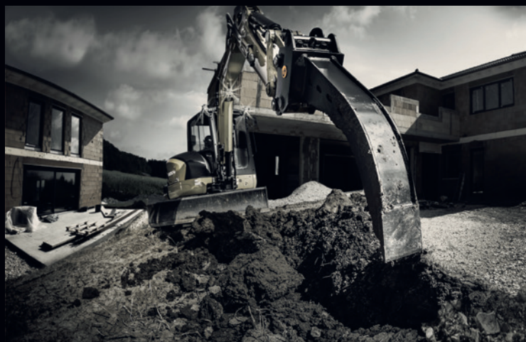
Teelöffel im Einsatz beim Kabelbau
